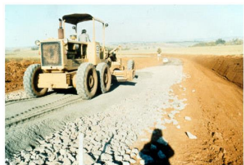
Figura 44 - Espalhamento do material de enchimento. A imagem mostra um trator amarelo espalhando um material de enchimento sobre a camada de pedregulhos já espalhada.
