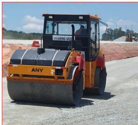
Figura 42 - Compactação da camada de macadame seco
