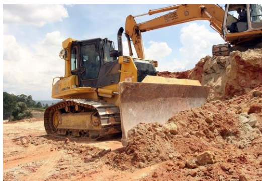
Figura 14 - Remoção do material estérreo
