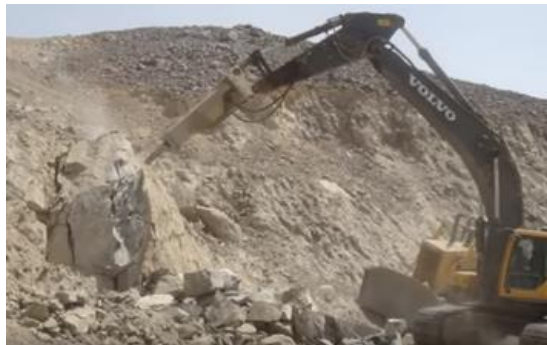
Figura 17 - Picão no desmonte de grandes blocos de rocha
