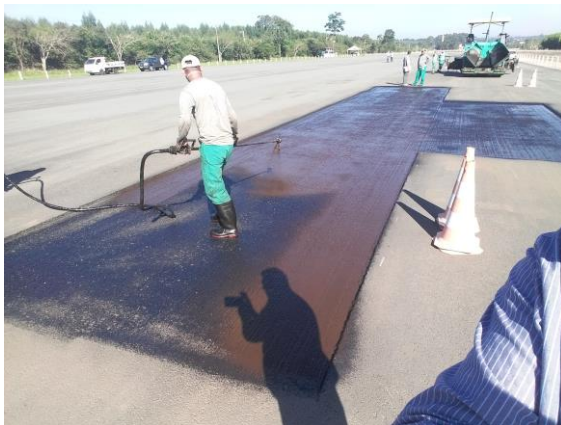
Figura 72 - Pintura de ligação com aplicação manual - Caneta
