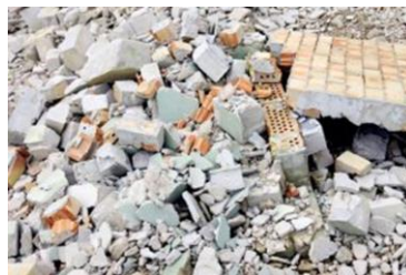
Figura 8- RCD após a demolição
