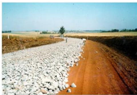
Figura 43 - Espalhamento da 1ª. camada de macadame seco.
