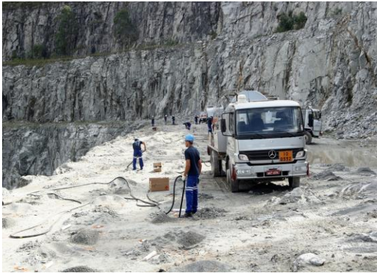
Figura 15 - bancada sendo preparada para o fogo
