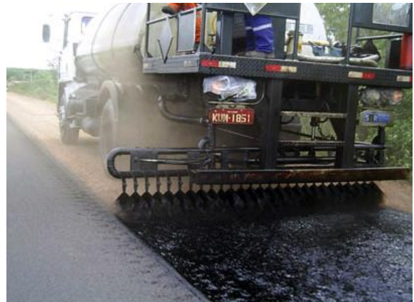
Figura 73 - Pintura de ligação com aplicação mecanizada
