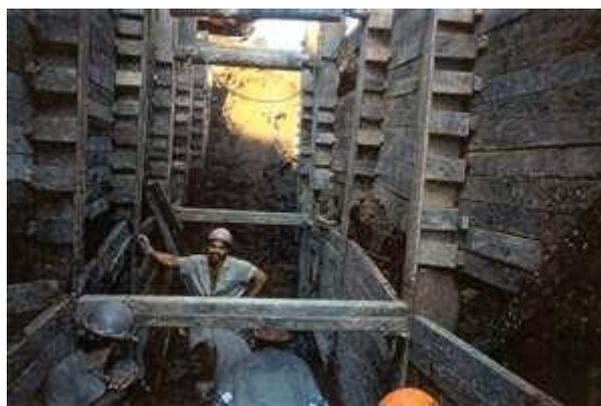
O escoramento deverá ter aberturas retangulares, verticais, com largura mínima de 10cm, dispostas nas paredes do poço de maneira a permitirem o exame de toda a sequência vertical do terreno.
