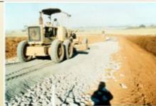
Figura 2 - Espalhamento do material de enchimento
