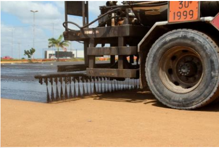
Serviço de imprimação
