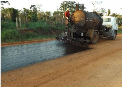
Serviço de imprimação
