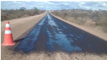
Camada em processo de cura após aplicação de pintura de imprimação
