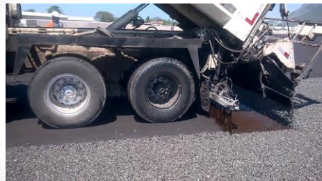
Tratamento superficial - penetração invertida
