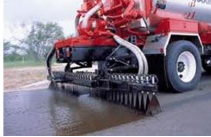
Serviço de imprimação
